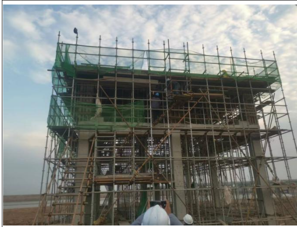
取水泵房施工
