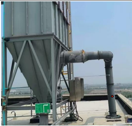
原料煤输送布袋除尘器
