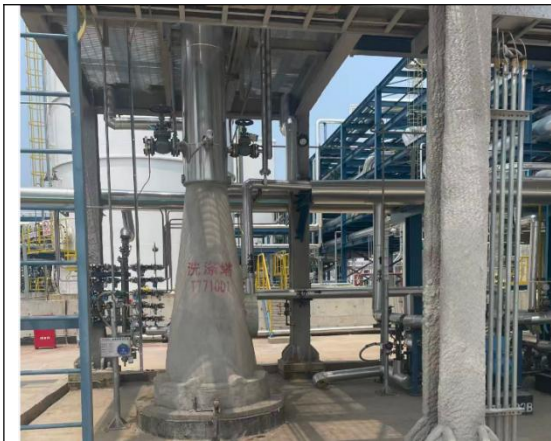
甲醇储罐呼吸废气处理设施
