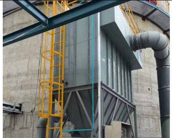
筒仓下部皮带受料点 3 废气处理设施
