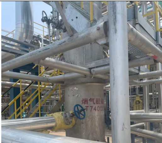
硫回收装置废气碱洗塔
