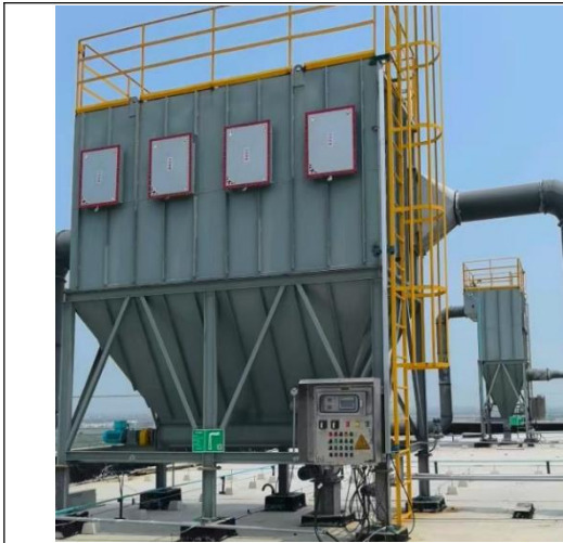
原料煤输送布袋除尘器
